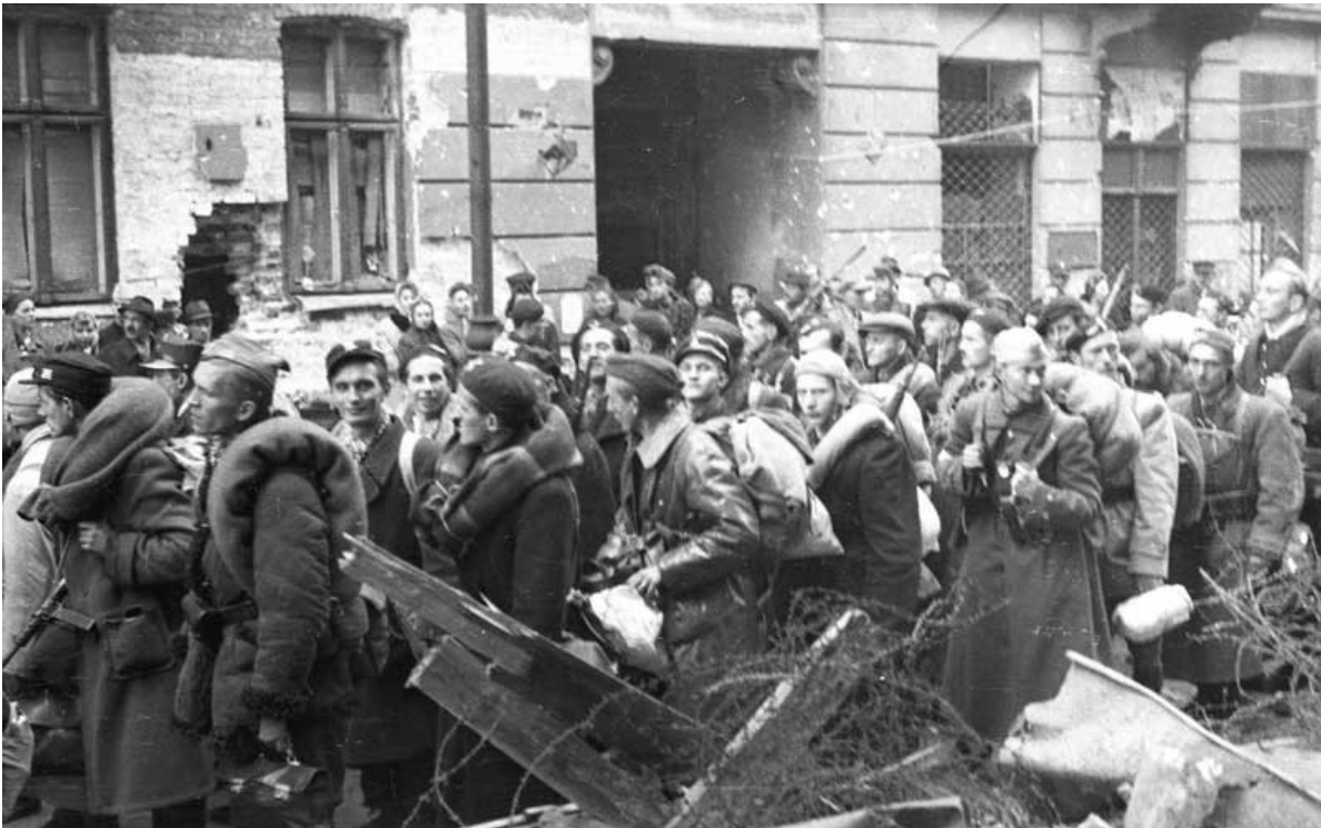
4 października 1944. Kolumna powstańców, idąca do niewoli ul. Śniadeckich nieopodal pl. Politechniki. Fot. Edward Wojciechowski.
