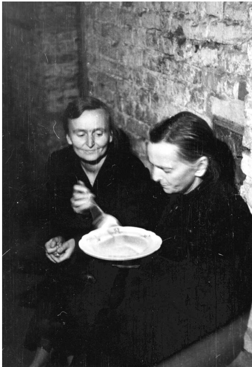
Pierwsza dekada 1944 r. Kobiety ukrywające się w piwnicy domu przy ul. Marszałkowskiej 127.
