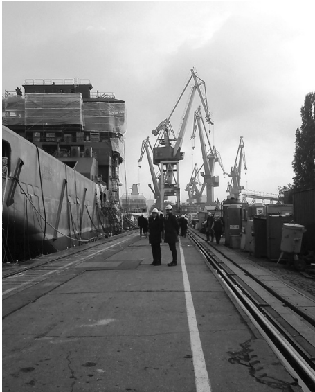
Przebudowany odcinek dawnej Drogi Broschkiego na terenie Stoczni Północnej
