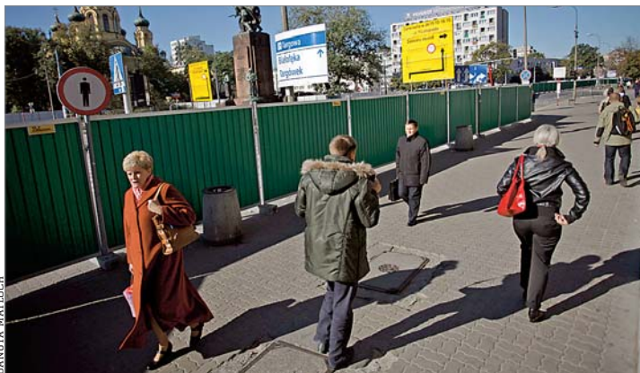
Budowa stacji metra na placu Wileńskim w Warszawie
