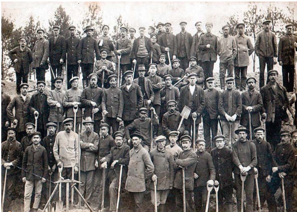
■ Robotnicy pracujący przy budowie linii kolejowej Łódź–Kutno. FOT. ARCHIWUM DOMINIKA KAŹMIERSKIEGO
