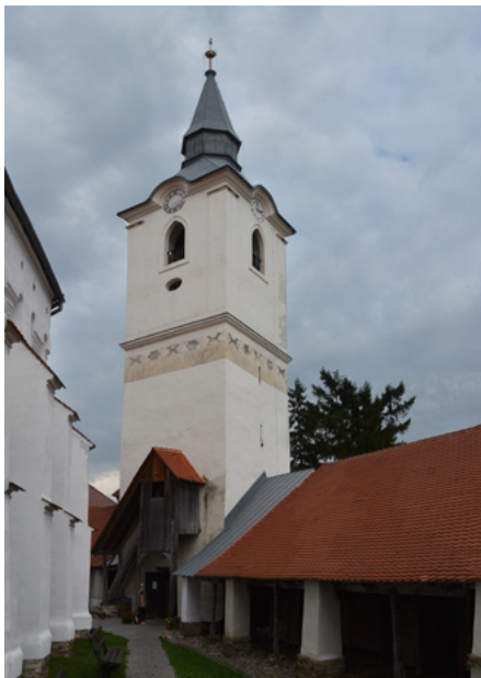
Wieża, elewacja północna i zachodnia
