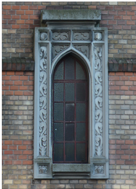
Okno elewacji północnej
