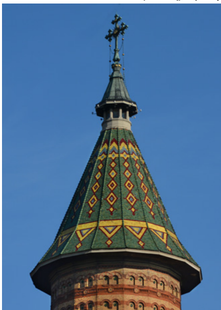
Wieża centralna (nad nawą), od północy
