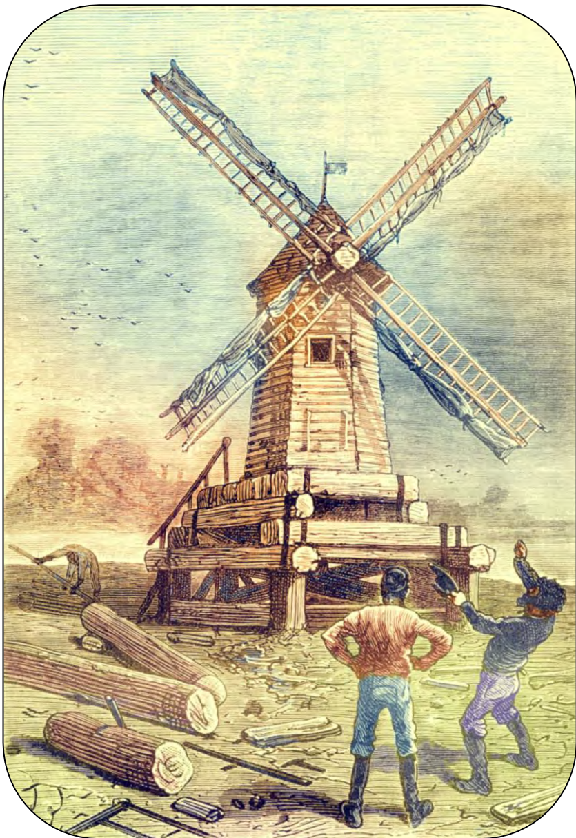
Wszyscy pracowali przy budowie młyna, który ukończono pierwszego grudnia.
