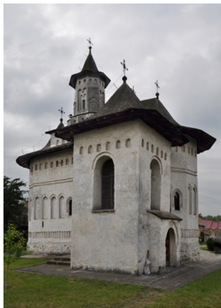
Elewacja północna, z wieżą dzwonnicyą
