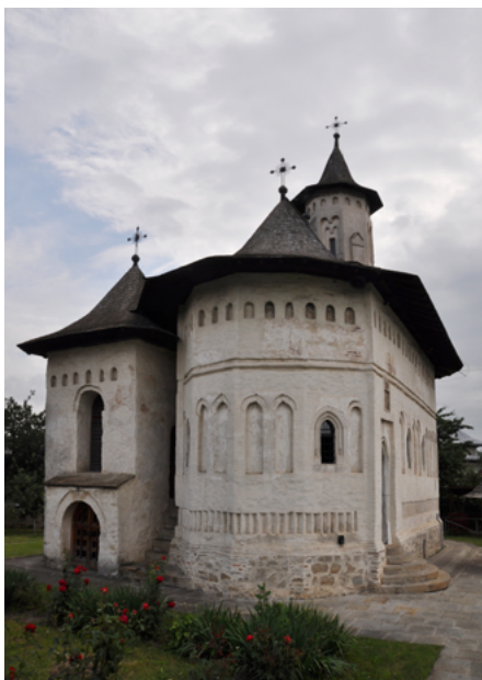
Elewacja zachodnia, z wieżą dzwonnicyą
