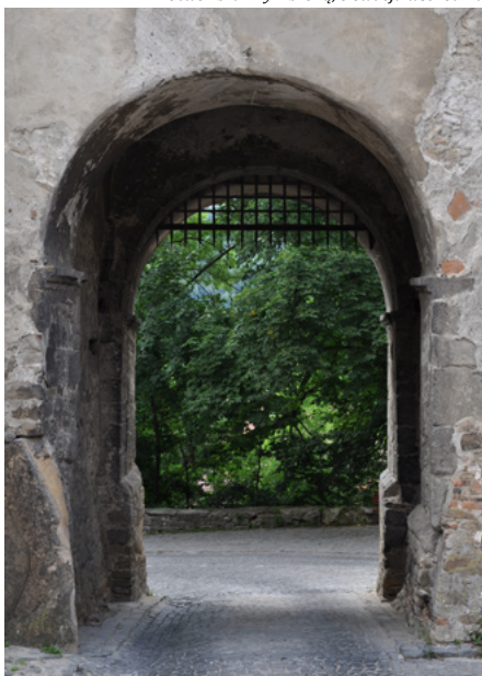
Otwór bramny z broną, elewacja wschodnia
