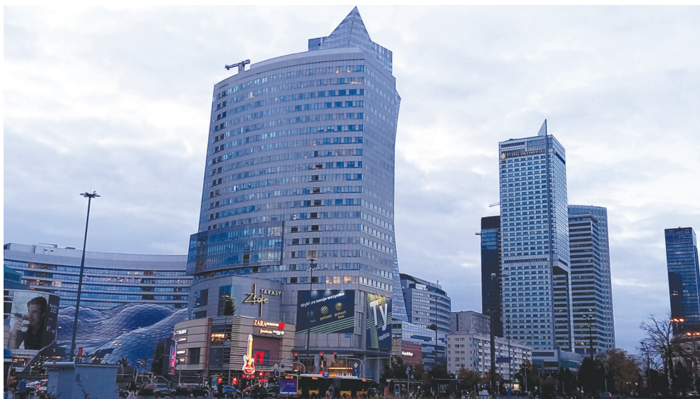
Fot. 2. Centrum Warszawy – dominacja budynków z elewacjami ze ścian osłonowych
