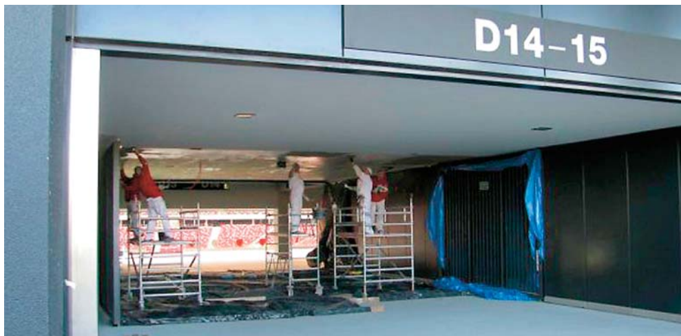
Historyczna naprawa sufitu nad przejściem dla kibiców Stadionu Narodowego, który się już oberwał i spadł
