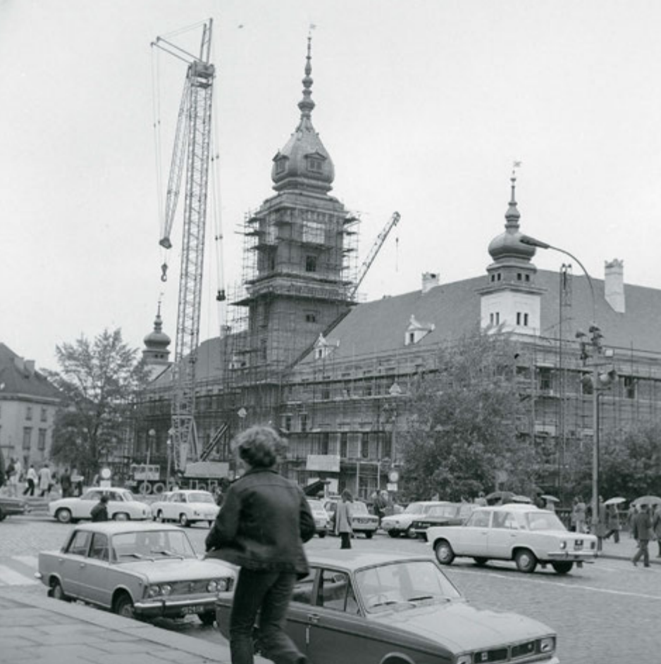
Końcowy etap odbudowy Zamku Królewskiego w Warszawie, 7 lipca 1974 r.
