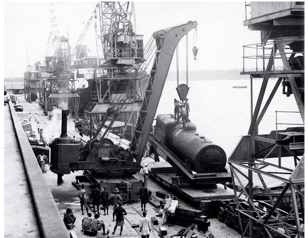
Port w Mombasie, rozładunek części pociągu dla zbudowanej linii kolejowej, Brytyjska Afryka Wschodnia (Kenia), lata 20. XX w.
