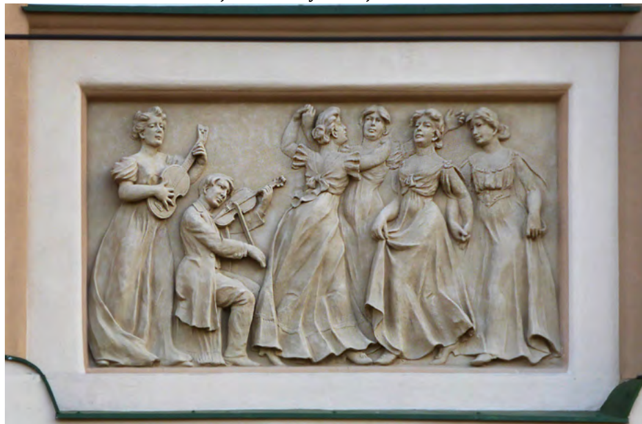
Stukowe reliefy, elewacja zachodnia
