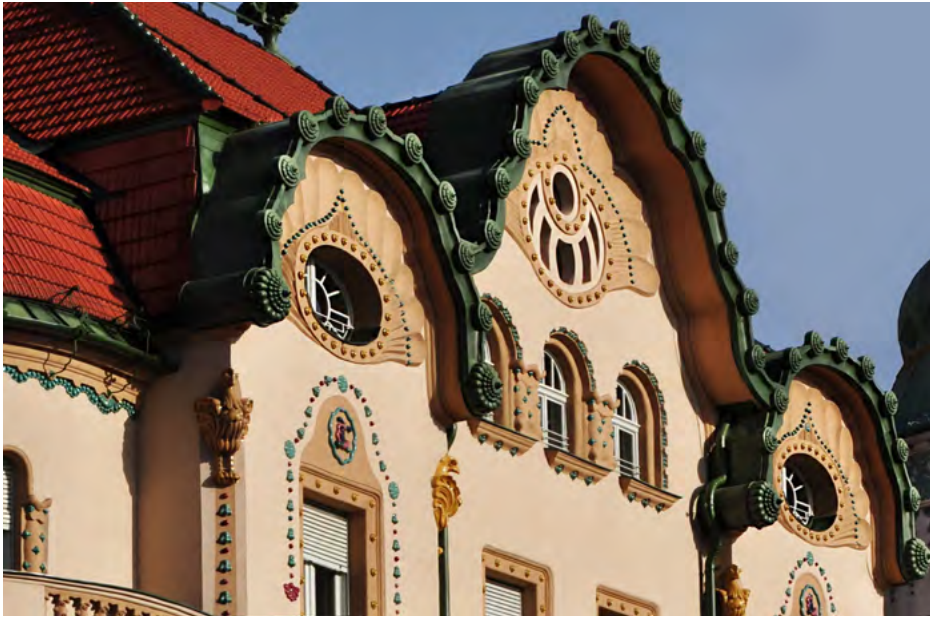
Secesyjne szczyty, elewacja zachodnia
