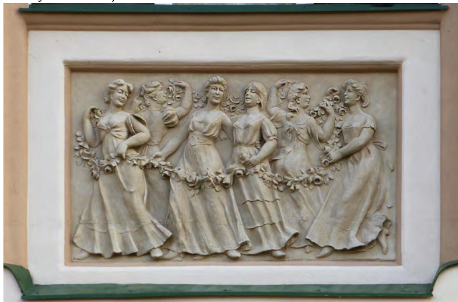
Stukowe reliefy, elewacja zachodnia
