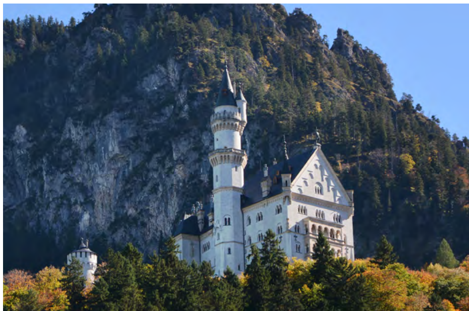
Elewacja zachodnia i północna pałacu (z ośmiokątną wieżą, najwyższą w zamku)
