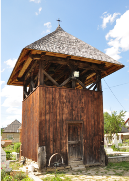
Dzwonnica, elewacja zachodnia i południowa
