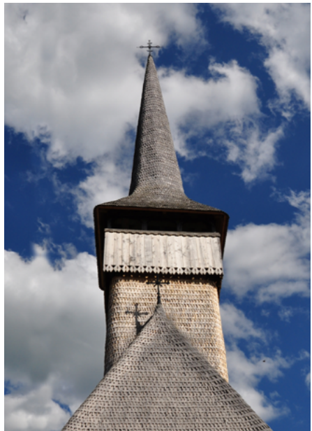
Dach gontowy, wieża z dachem gontowym
