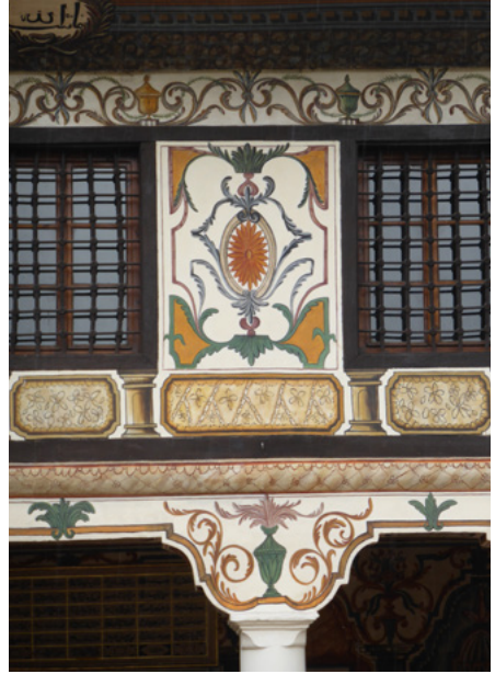
Detale elewacji północnej
