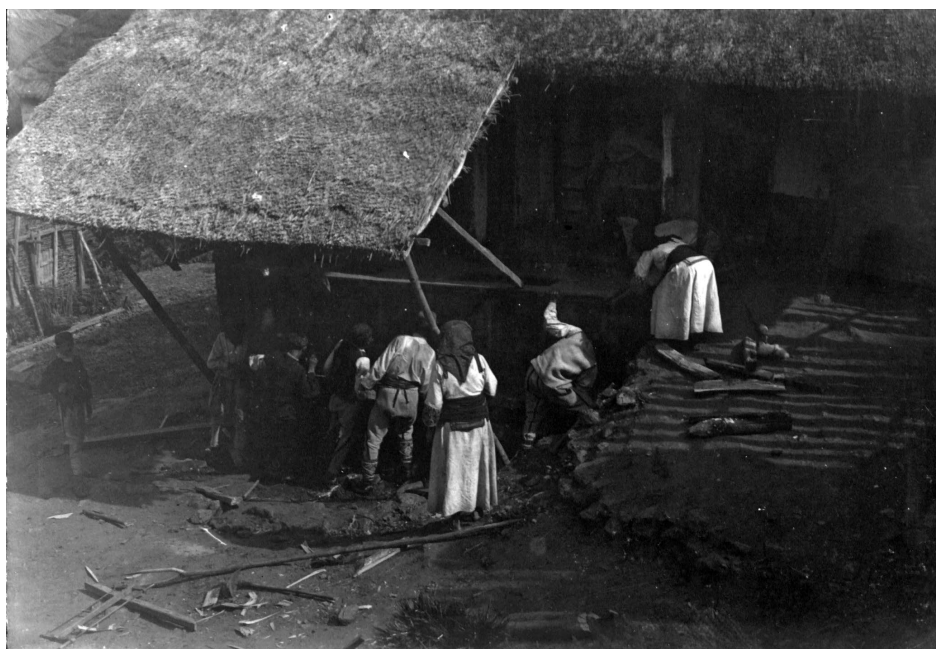
Wolcze. Budowa ambara
