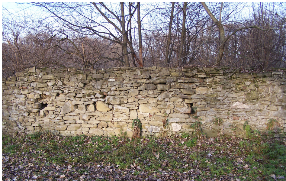
Fot. 26. Fragment starego muru obronnego od strony Dunajca
