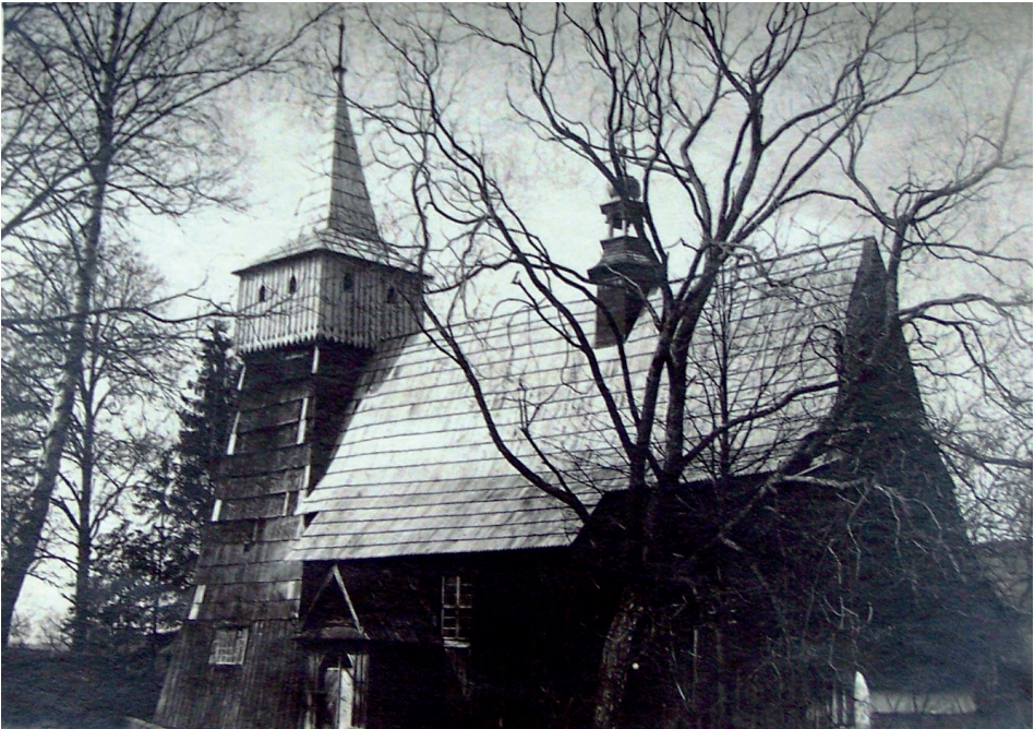
Fot. 29. Kościół przed generalnym remontem w 1932 r. Arch. J. Kietlińskiej
