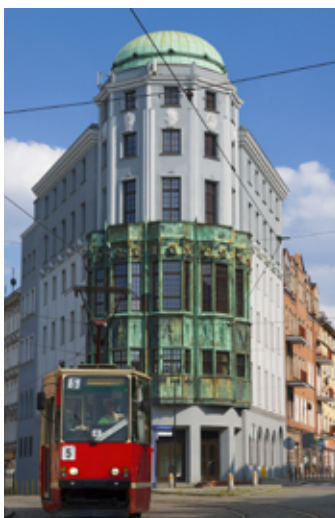
▲ Przykład architektury Zabrze
