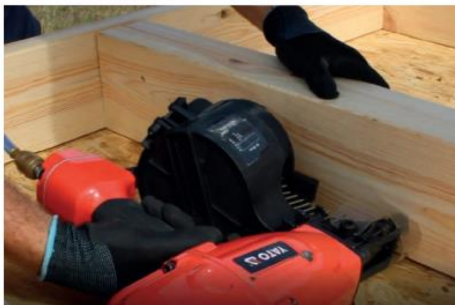
Zbijanie ścian domku gwoździarką
