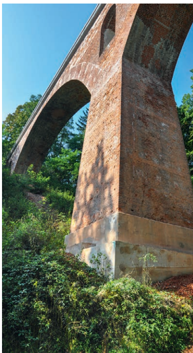
▶ Wiadukt na trasie Kolei Sowiogórskiej
