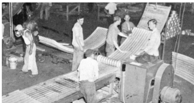
Rys. 2.2. Proces zakrzywiania blach profilowanych (1941) [3]
