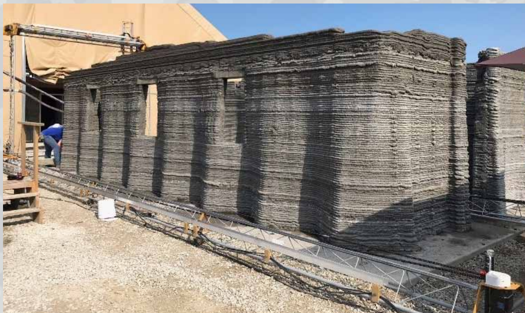
Fot. 1-3. Marines z Marine Expeditionary Force monitorują komputer, podczas gdy największa na świecie drukarka do betonu 3D buduje barak o powierzchni 500 m 2 w Centrum Badań i Rozwoju Inżynierii Armii Amerykańskiej (U.S. Army Engineer Research and Development Center) w Champaign w stanie Illinois (USA). Źródło: https://www.marines.mil/News/News-Display/Article/1611532/mcsc-teams-with-marines-to-build-worlds-first-continuous-3d-printed-concrete-ba/ (dostęp: 31.08.2018).
