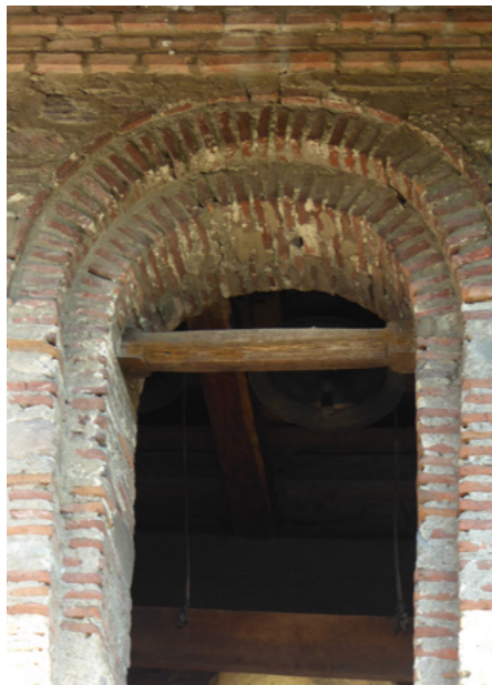
Okno wieży dzwonnicej
