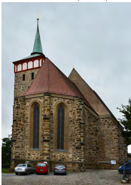
Elewacja wschodnia, prezbiterium
