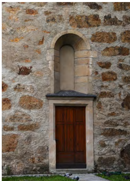
Drzwi do dzwonnicy, od wschodu
