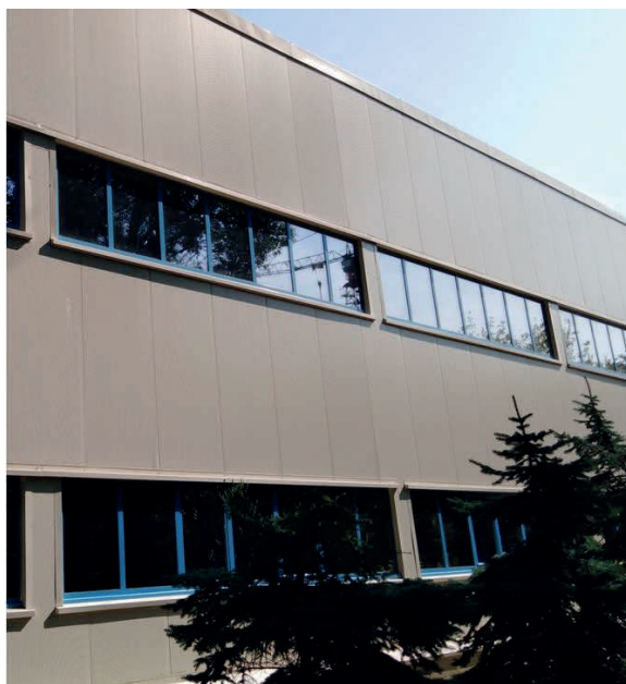
Fot. 1. Płyty warstwowe w ścianach zewnętrznych hali badawczej ITB
