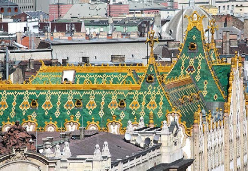
Pocztowa Kasa Oszczędności Kryty barwną dachówką dach budynku.
