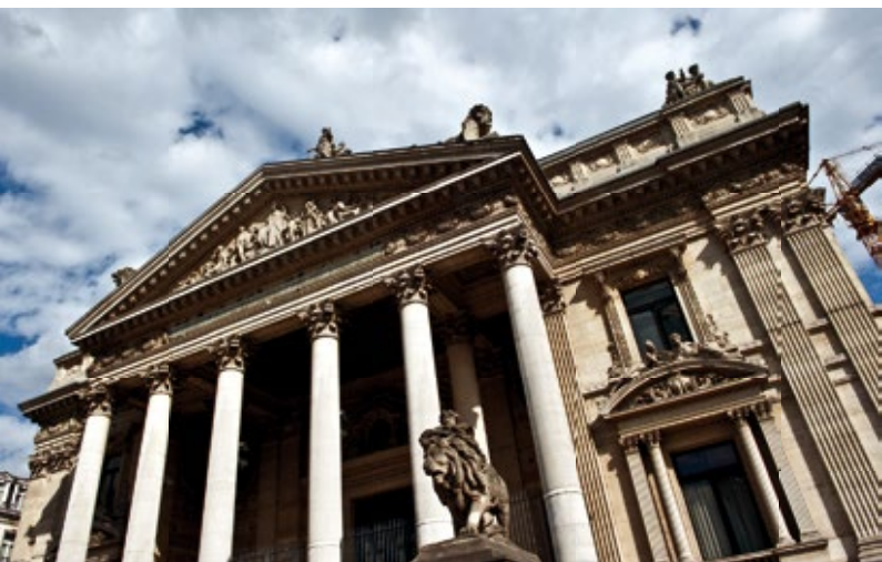
Monumentalny budynek Giełdy
