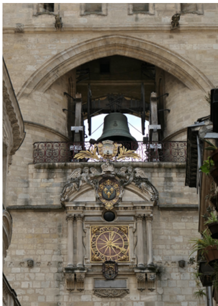
Elewacja północna (od rue Saint James)
