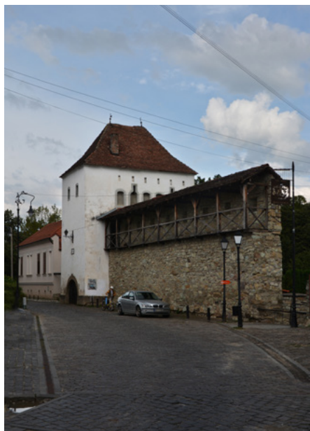
Fragment murów, elewacja północna
