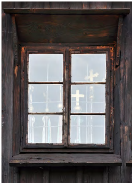
Okno w nawie, elewacja północna
