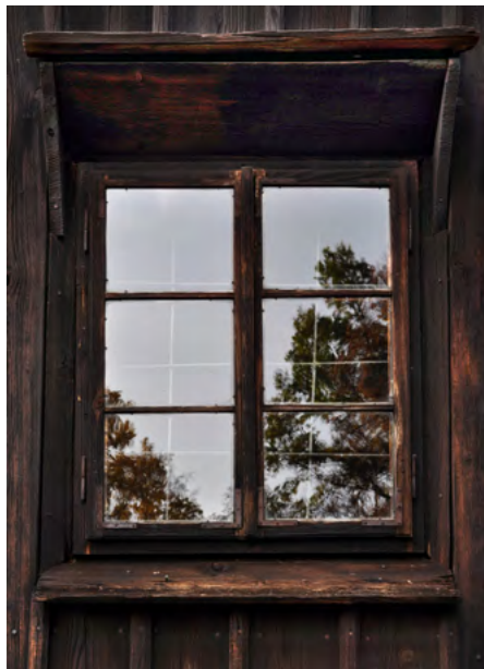
Okno w nawie, elewacja południowa
